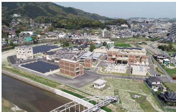
東隈浄水場全景
