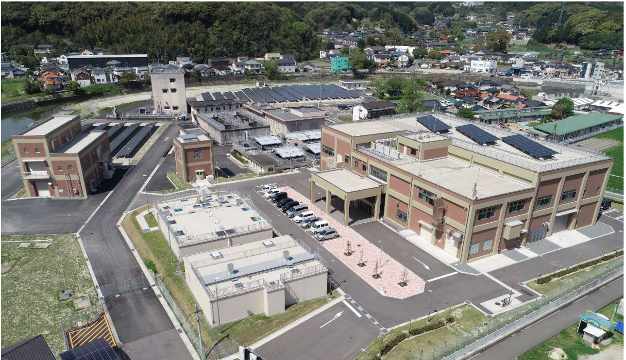
東隈浄水場全景
