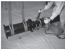
図45 継ぎ輪の先行管への引き込み
