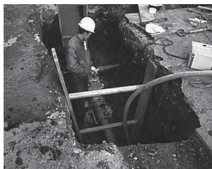
水中ポンプを用いた施工
