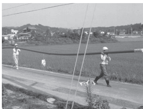
長尺管の運搬
