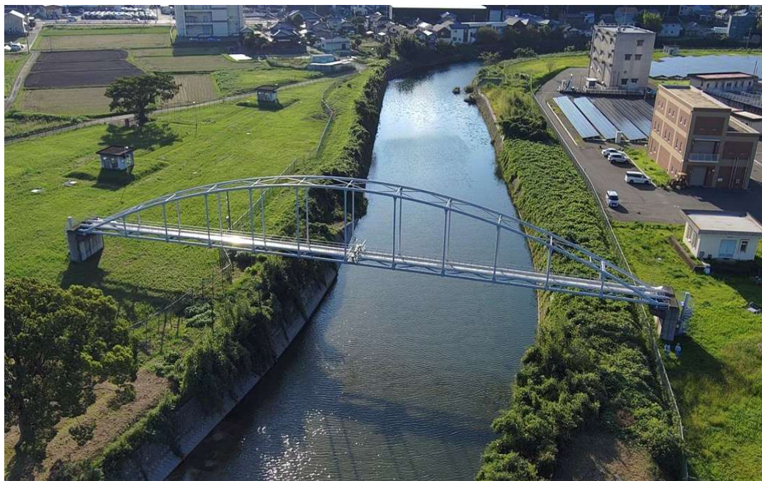
東隈浄水場(水管橋)
