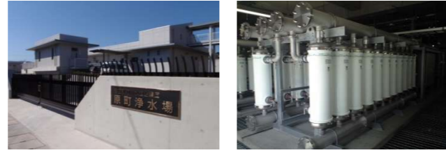
【原町浄水場】 施設能力：3,375m 3 /日 処理方式：上向流活性炭+膜ろ過方式
