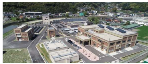
【東隈浄水場】 施設能力：22,000m 3 /日 処理方式：粉末活性炭+膜ろ過方式
