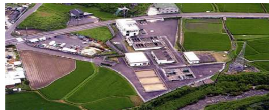
【埋金浄水場】 施設能力：7,000m 3 /日 処理方式：急速ろ過方式
