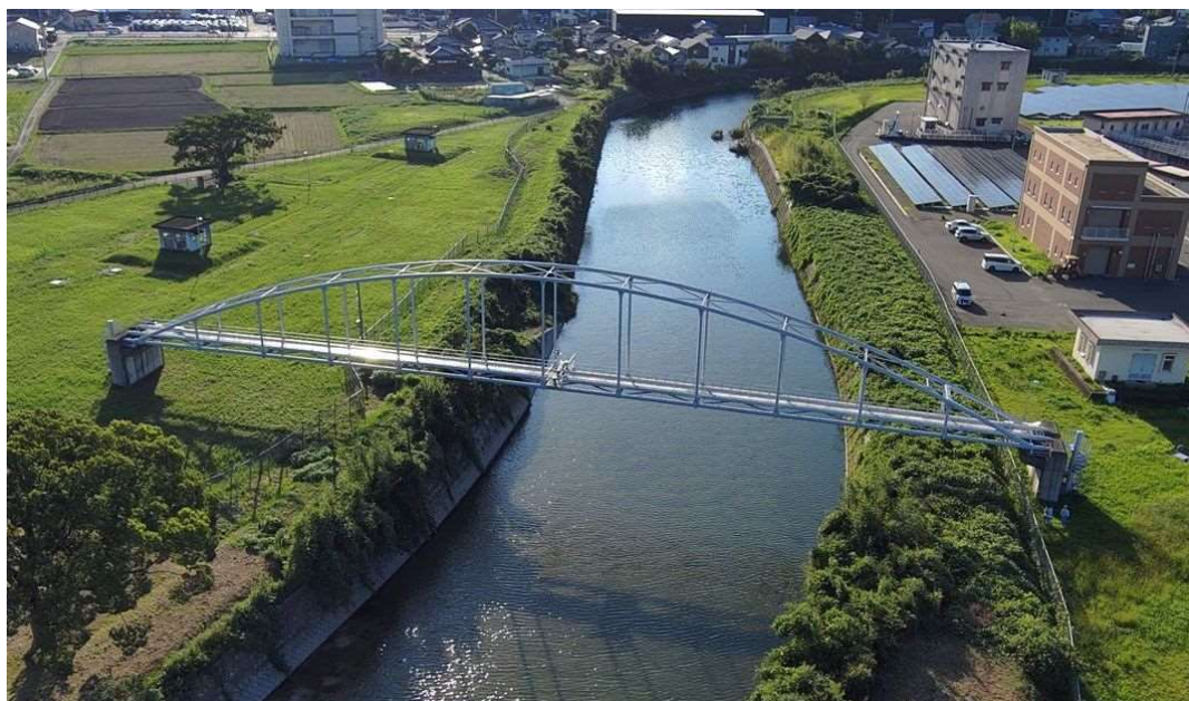
東隈浄水場 (水管橋)
