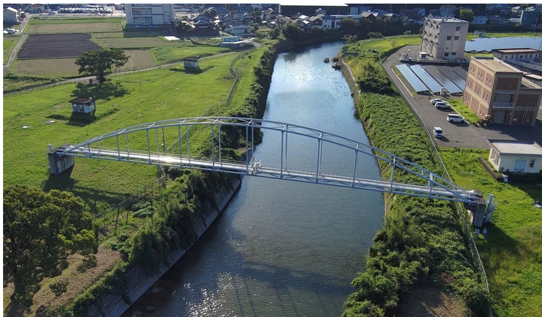
東隈浄水場(水管橋)
