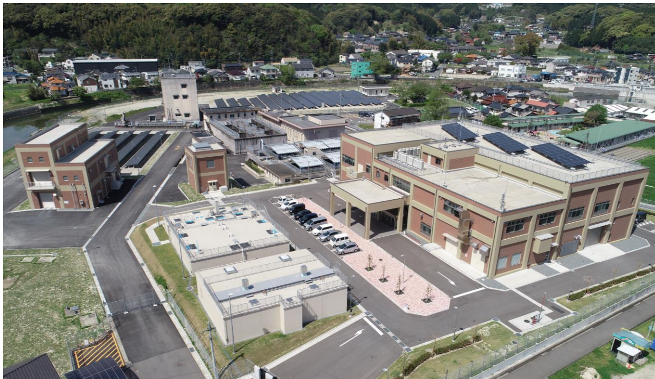
東隈浄水場全景
