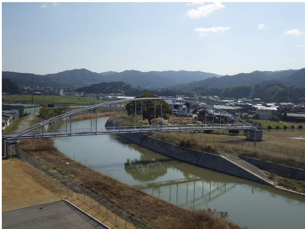
東隈浄水場（水管橋）
