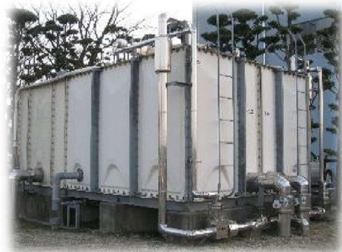
貯水槽（受水槽）
