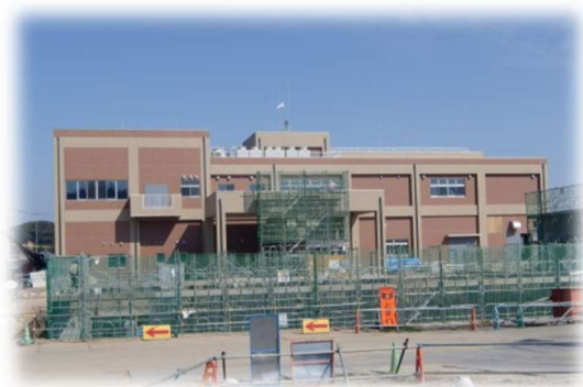
東隈浄水場施設改良事業工事
