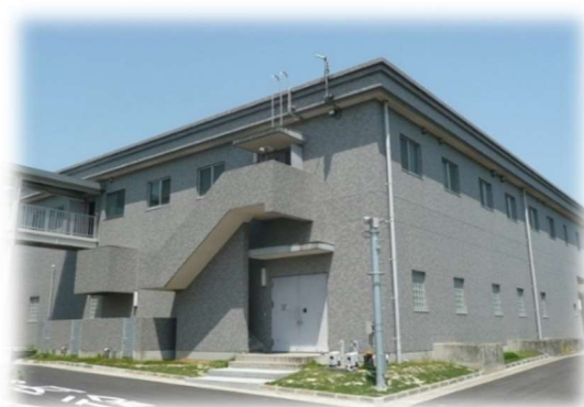
原町配水池（地下式）
