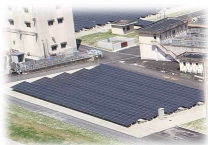
東隈浄水場 太陽光発電システム
