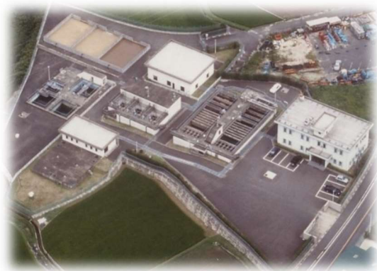
埋金浄水場 (空撮)
