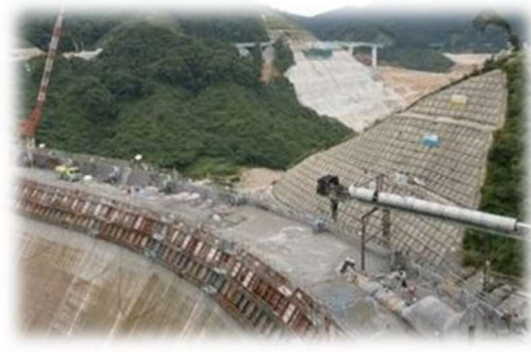
五ヶ山ダム建設事業工事
