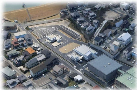
原町浄水場（空撮）
