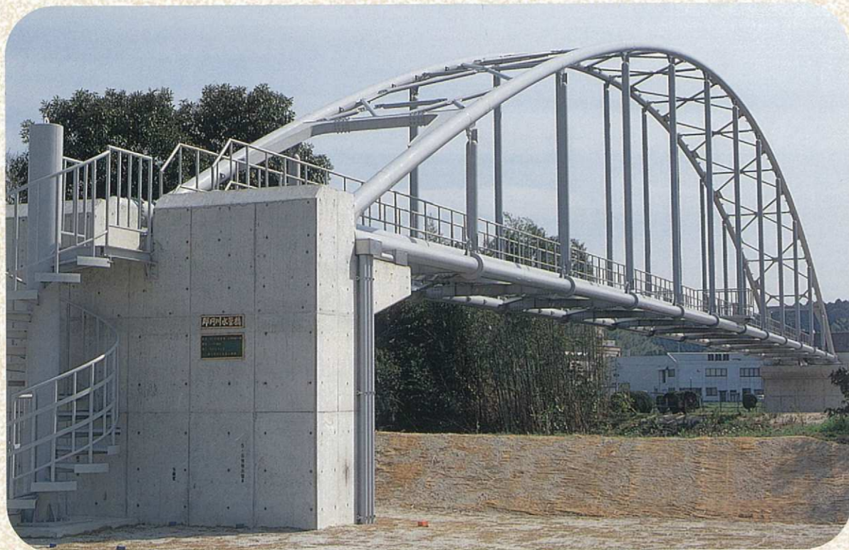
那珂川水管橋（那珂川市東隈）平成12年3月完成
