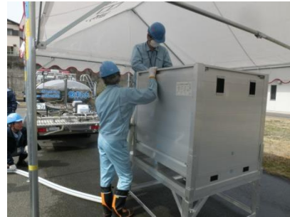
↑ 応急給水訓練の様子です。給水車の操作確認、パネル式給水タンクの組立て等を行いました。
