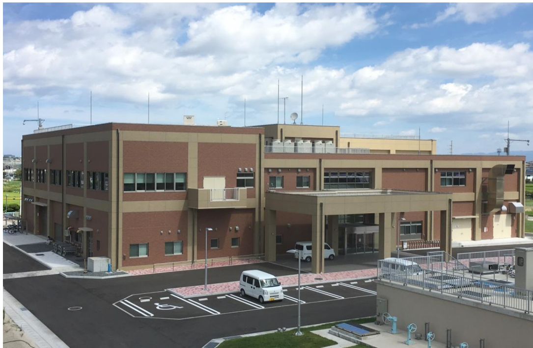
膜ろ過管理棟
