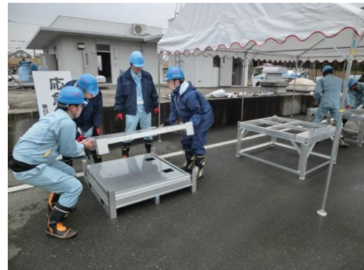
仮設給水タンク設置訓練
