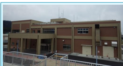
【膜ろ過管理棟】
